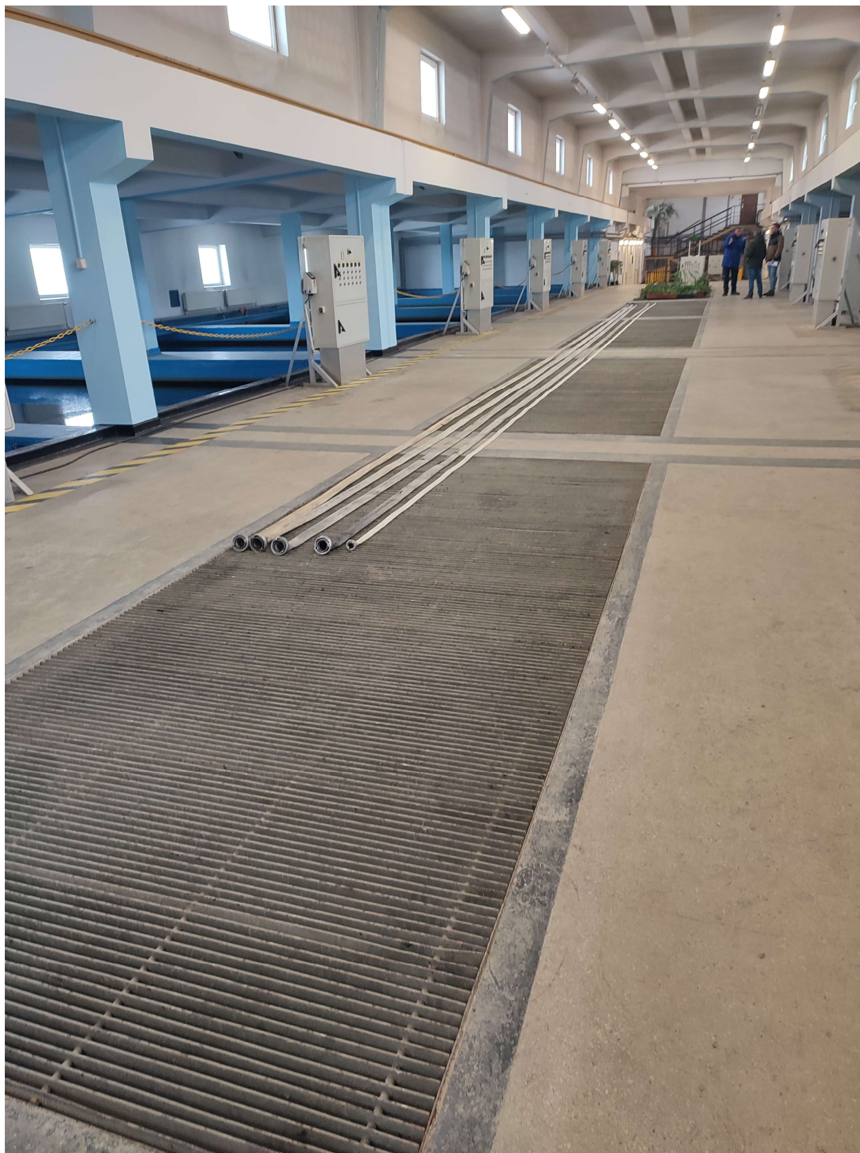
Widok zachodniej części hali z suwnicą i kratami WEMA
